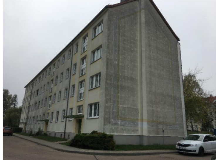
Abbildung 29: Gebäude Auf dem Walzel
