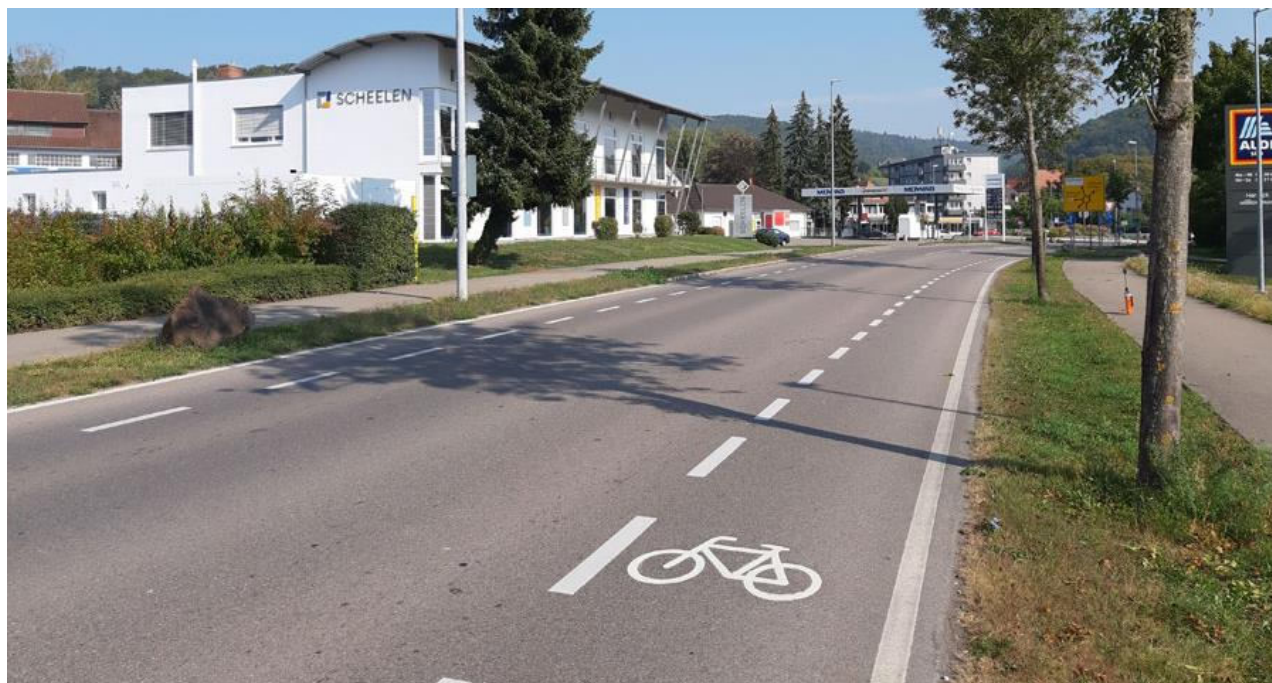
Abbildung 102: Schutzstreifen entlang einer Straße Quelle: Herbst o.J.
