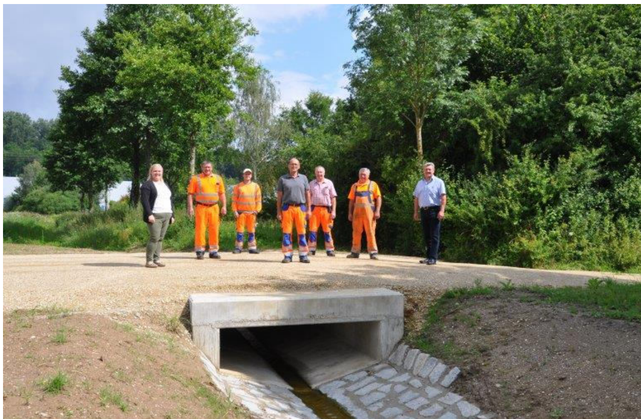
Abbildung 99: Gestaltung des Hochwasserschutzes in Moosthenning Quelle: Gemeinde Moosthenning o.J.
