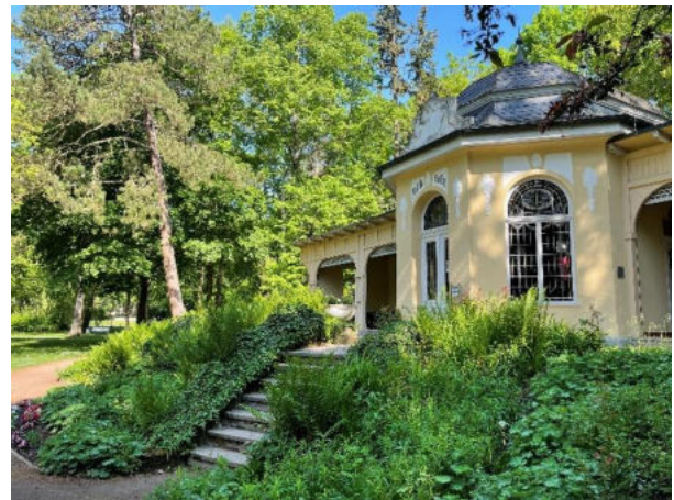
Abbildung 60: Trinkhalle Quelle: DSK
