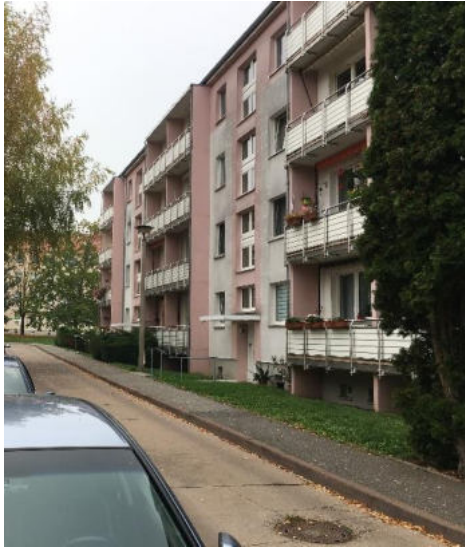
Abbildung 28: Gebäude Auf dem Walzel
